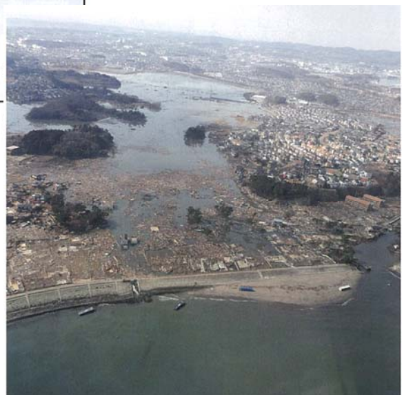
右下の菫蒲田海水浴場付近は、密集していた家屋が跡形もなくなった(七ヶ浜町提供)
